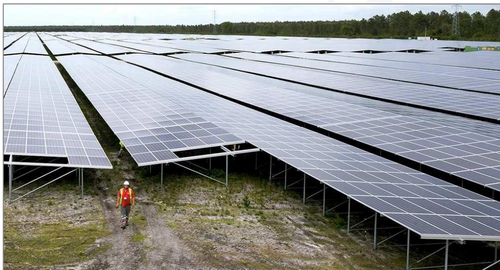
Parc solaire de Cestas (Source : NEOEN)
